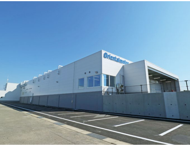
堆高后的能代东方马达厂房
